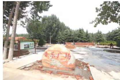
葛家庄村音乐广场施工现场
