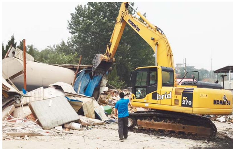
挖掘机对非法垃圾转运站进行拆除。
