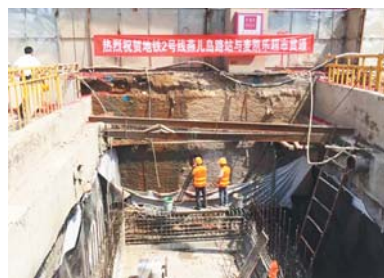
地铁二号线与麦凯乐贯通的施工现场。
