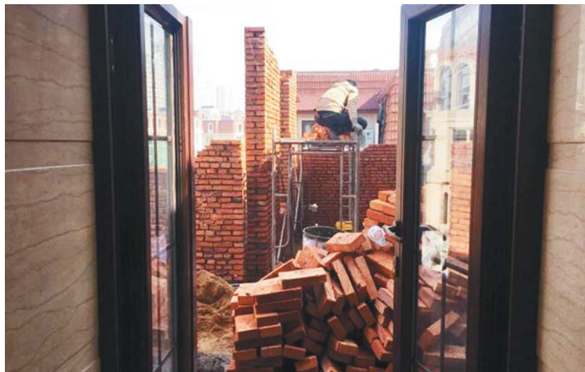
“空中楼阁”拆除前。
