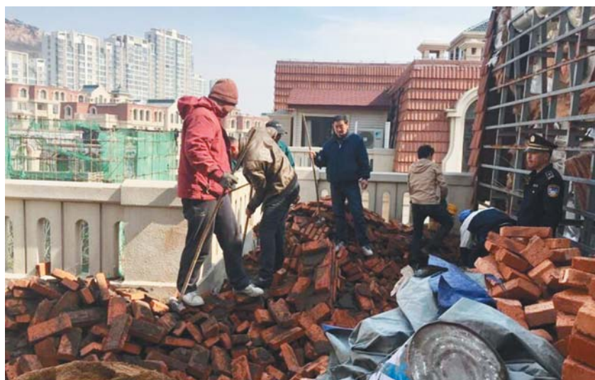
拆除“空中楼阁”。
