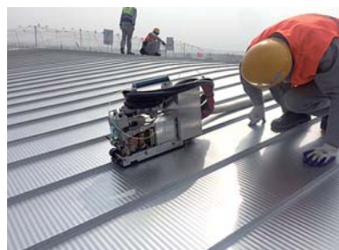
所有接缝采用全自动焊机焊接。
