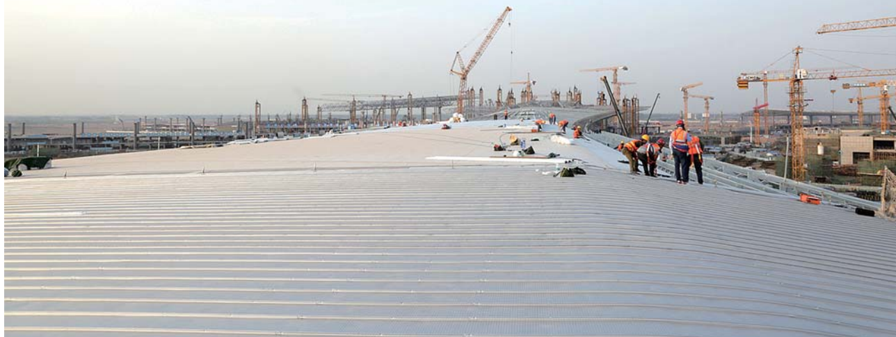
工人们在试拼接安装新机场不锈钢屋面。
