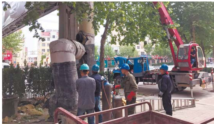
胜利路供热桁架拆除。
