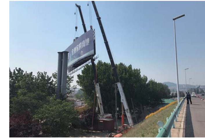
青银高速出口处的一违法高炮被拆除。
