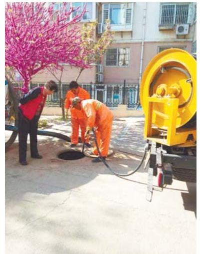
排水公司工作人员正在疏通污水井。(徐州路社区供图)
