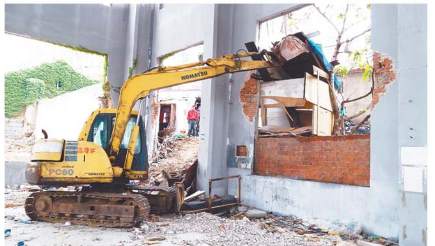
工人正在开着挖掘机进行拆除。
