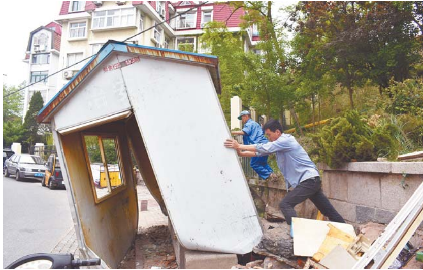
施工队拆除伏龙路上的违建看车亭。
