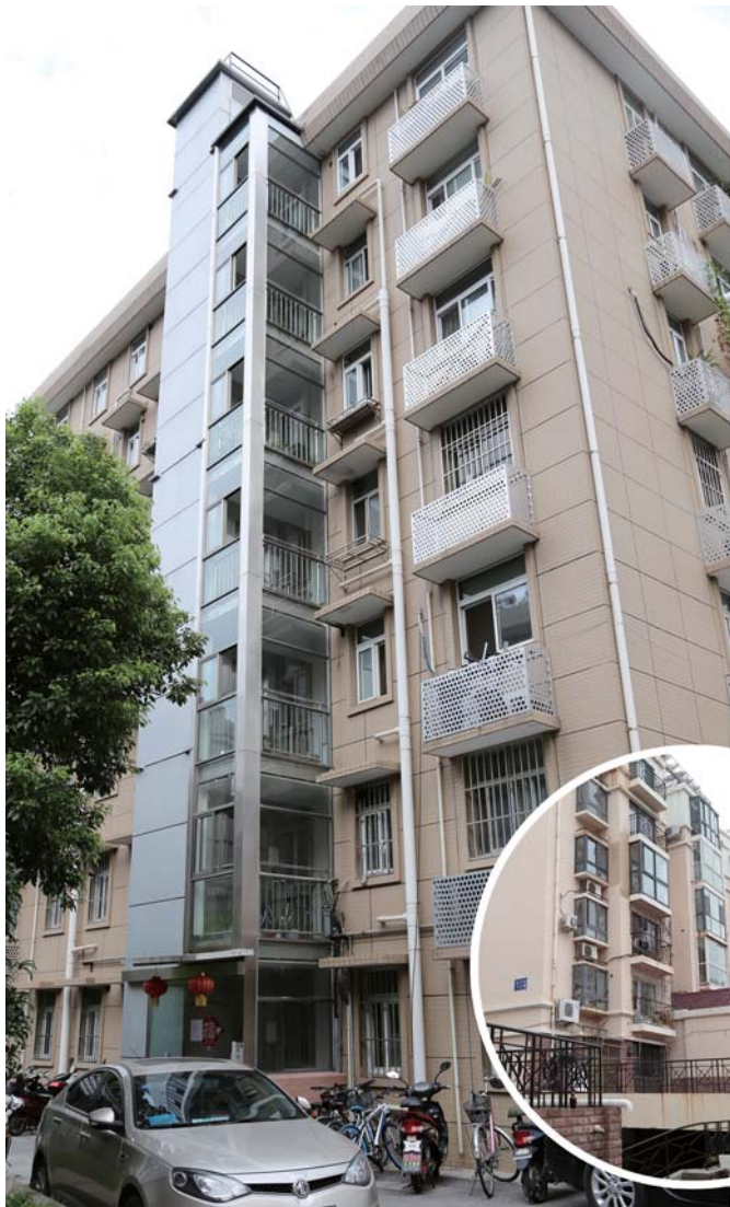
◀岛城一 电梯公司在南 京一小区拍摄 的一座老楼加 装的电梯。
