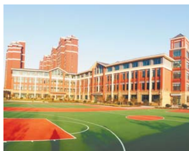
开发区二小提档升级，新投入使用的教学楼。
