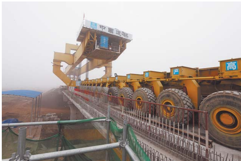
工程机械正在施工中。
