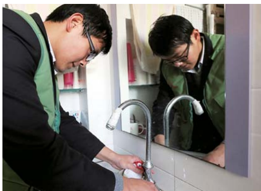
居民家水龙头坏了志愿者也会帮着修。
