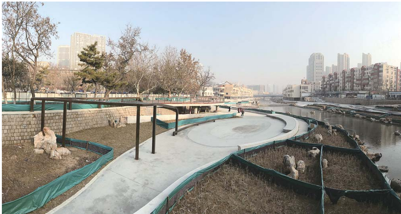
改造后的李村河中游景观错落有致，还有步行栈道，成为居民休闲健身的好去处。
