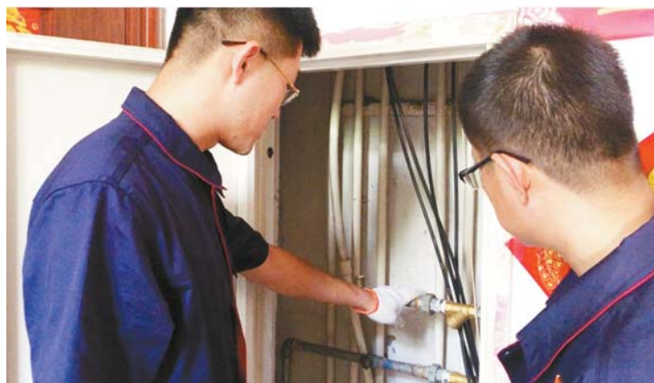
党员入户,为群众进行供暖管线检修。
