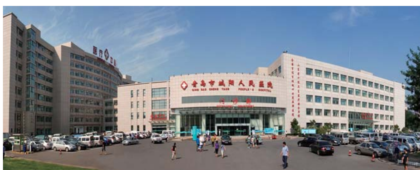
青岛市城阳区人民医院。
