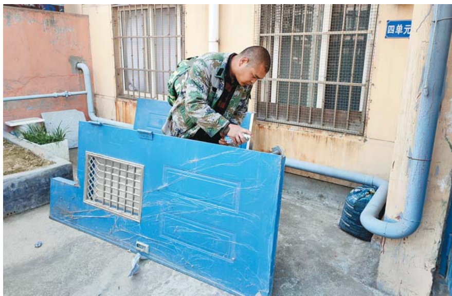
工人对生锈部分进行处理。
