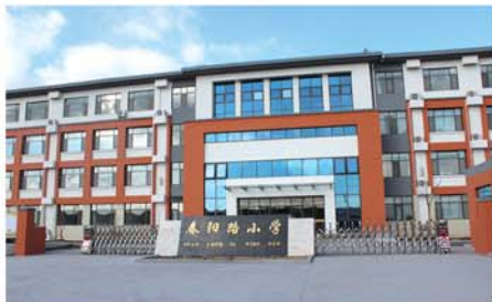
春阳路小学新建学校
