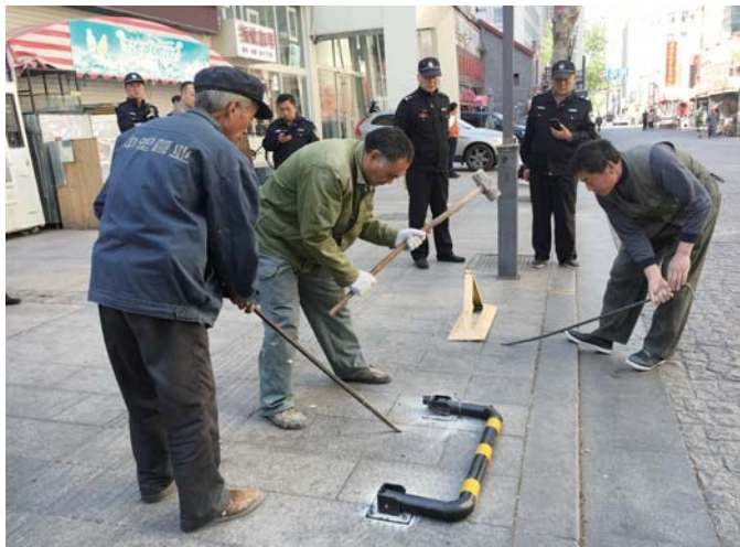
工作人员拆除占地地锁。
