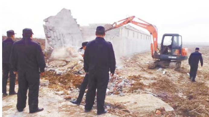
执法队员拆除违法建筑。
