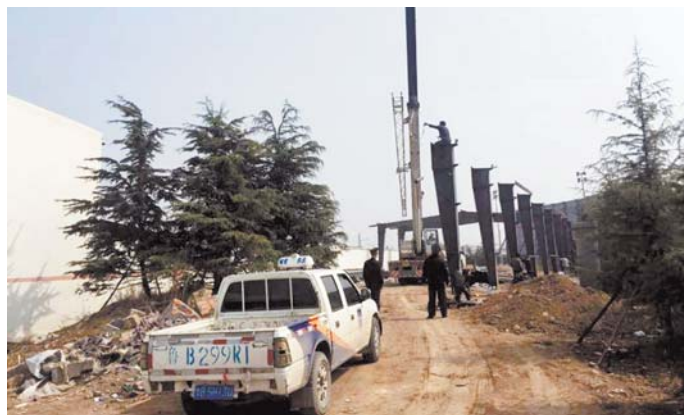
李沧城阳两区城管联合执法,拆除区界千余平方米违建。
