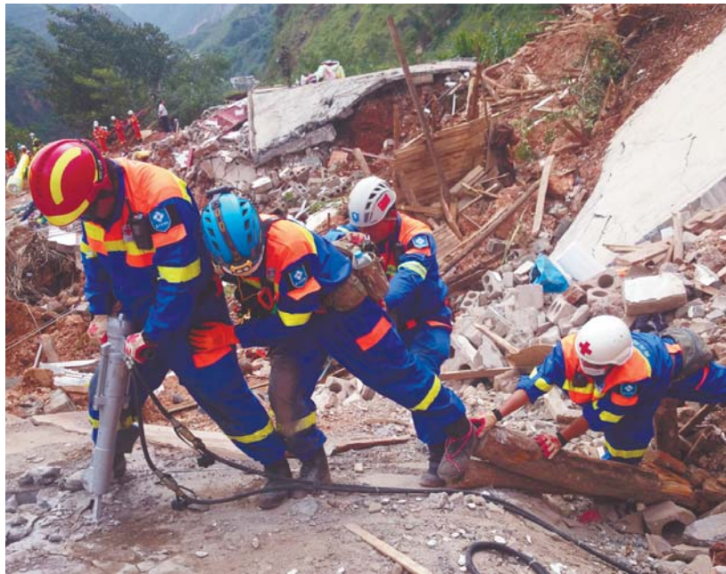
鲁甸地震救援时，朱光鹏在破拆工作面。
