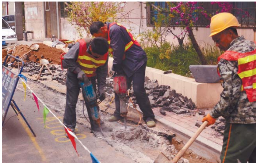
工人正在对楼院内排污管道进行改造。
