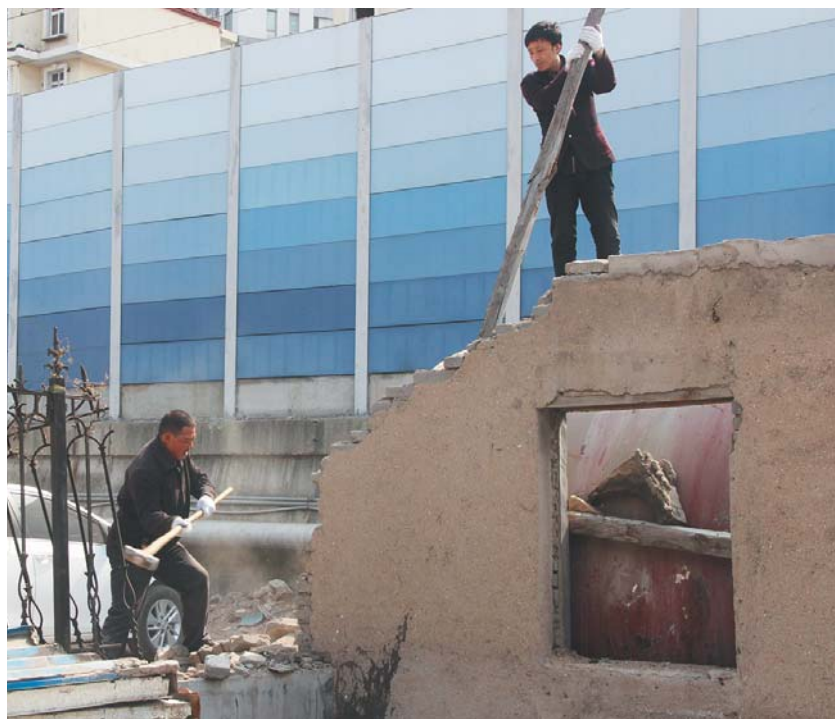
拆除违法建设现场。
