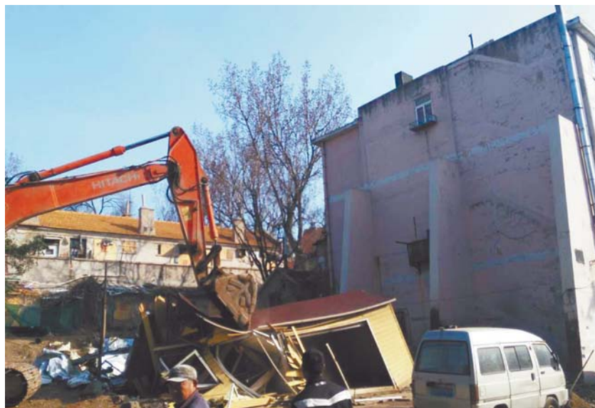
运用大型机械拆除违法建设。(江苏路街道办事处供图)
