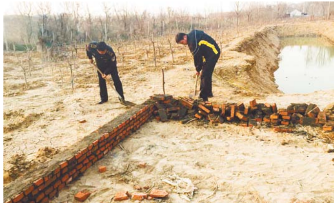
执法人员拆除新生违法建筑。
