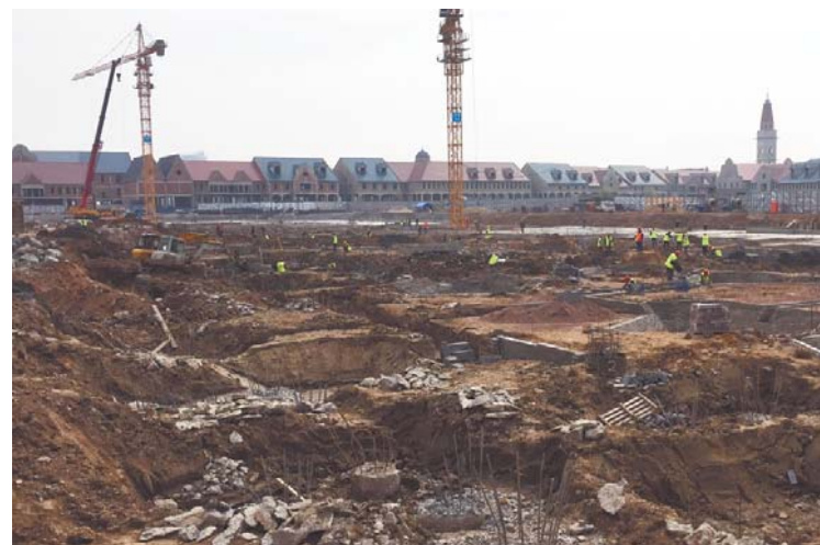
工人正在紧张施工。
