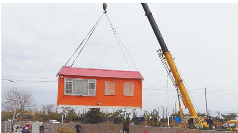
吊车将银海大世界附近的违法建筑吊起清理。
