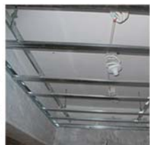
轻钢龙骨吊顶,质量较轻硬度大,是天花吊顶主要材料
