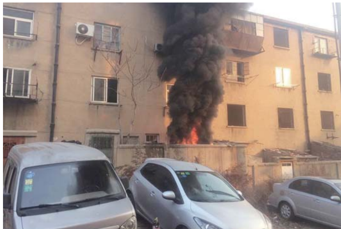
▲起火现场浓烟滚滚。
