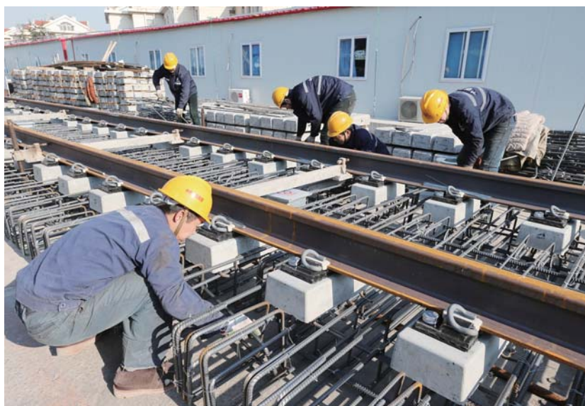
地铁2号线的工人们正在忙碌施工。
