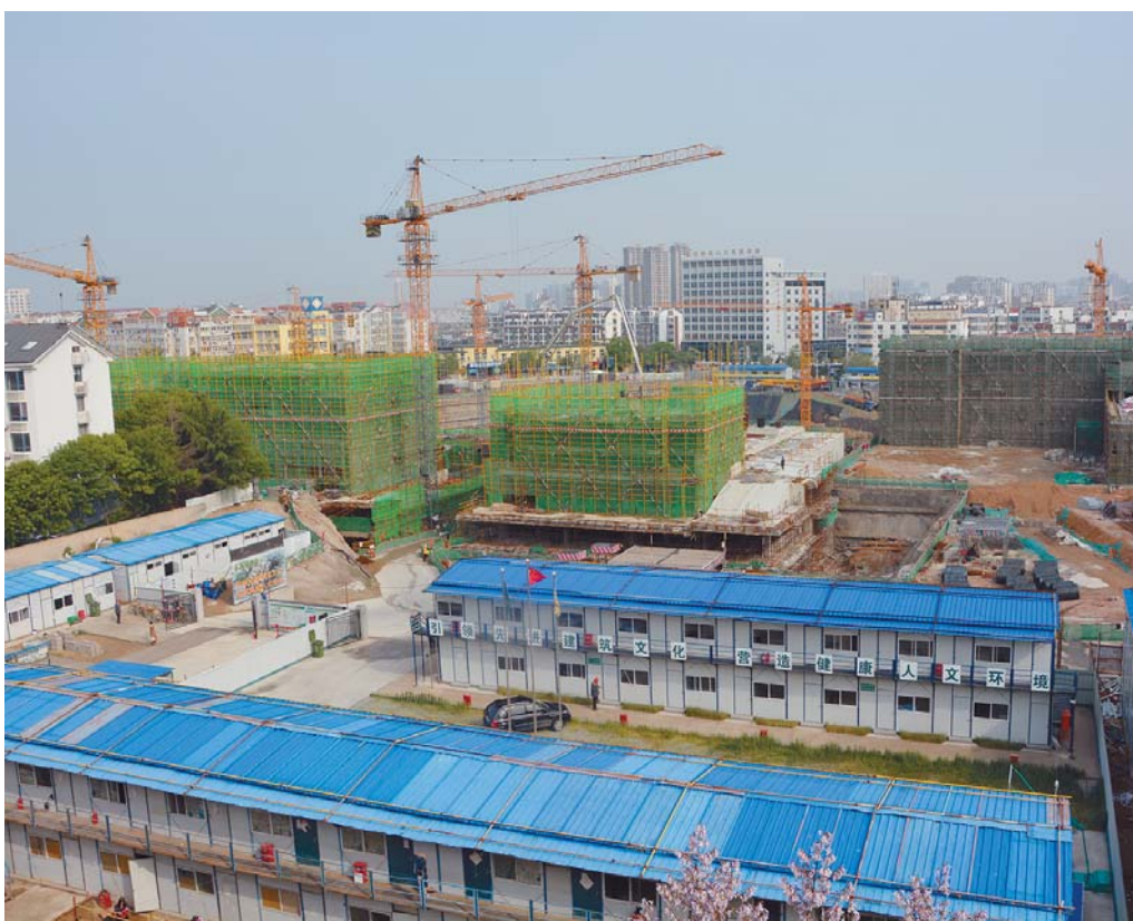
大集搬迁后这里正在建设居民楼。
