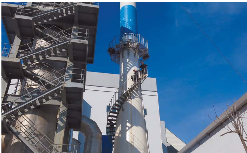
环境监测人员对锅炉废气排放情况进行监测(资料照片)。
